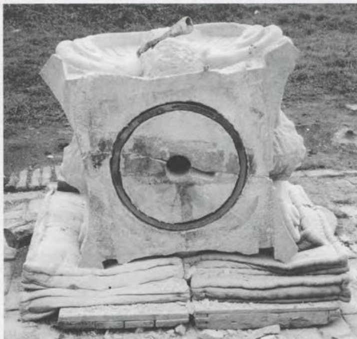
Ukládání ztužujícího prstence do hlavice (horní plocha).
