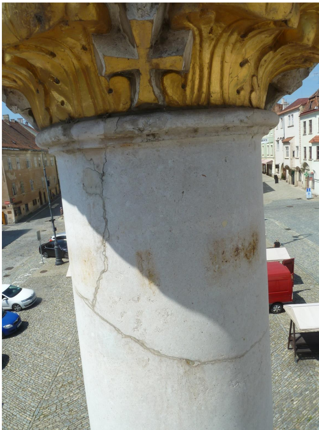
Dřík sloupu – čelní strana (SZ) Přetmelené praskliny.
