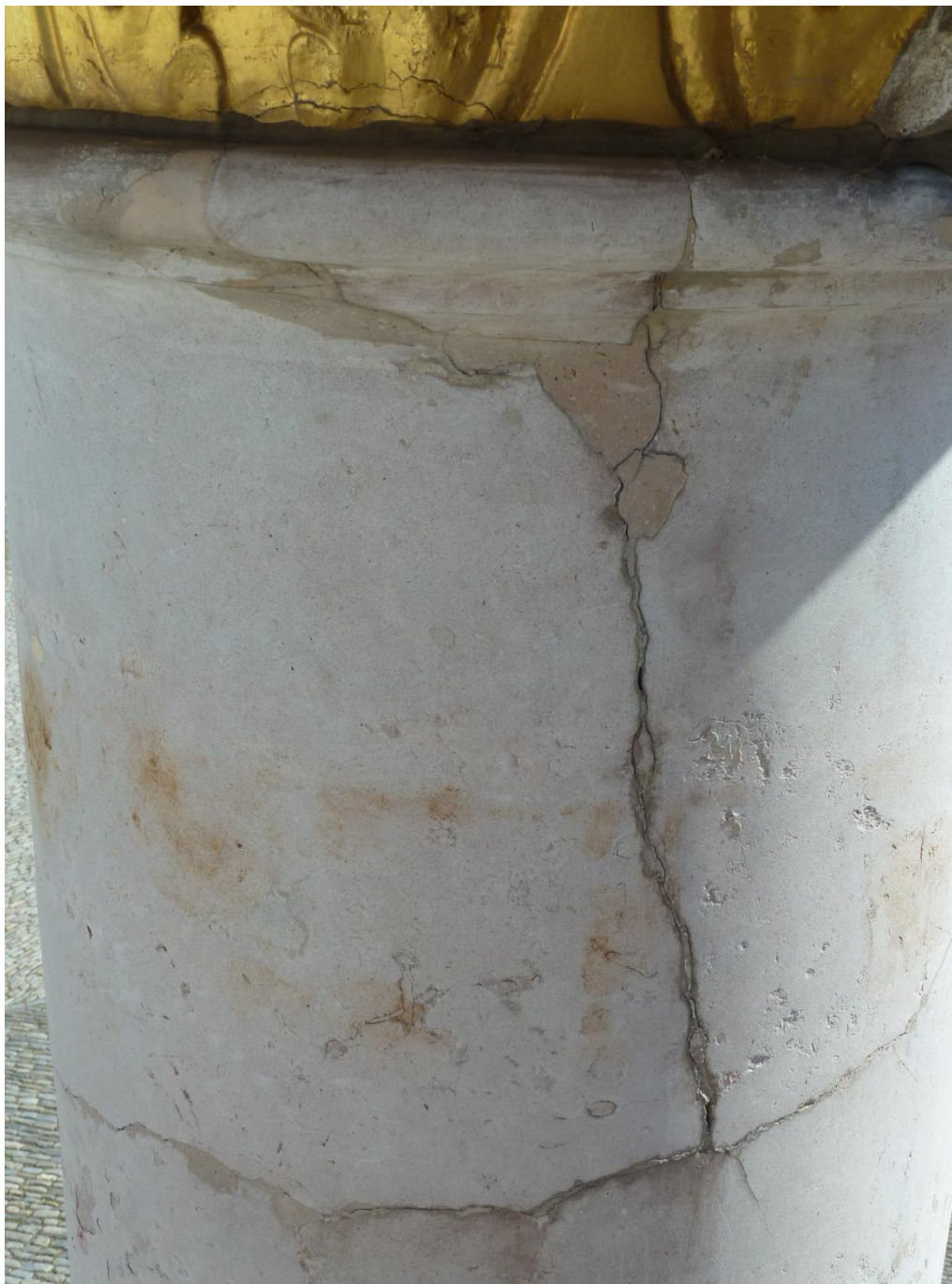
Dřík sloupu – zadní strana (JV) Přetmelené praskliny.
