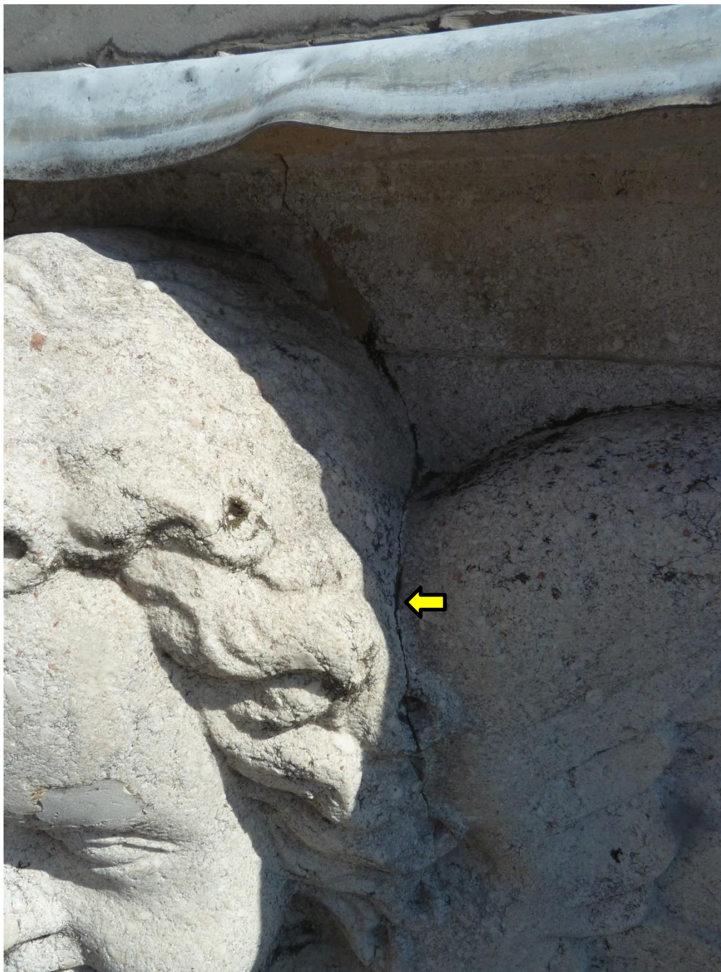
Hlavice – zadní strana (JV) Vertikální prasklina za hlavičkou anděla.
