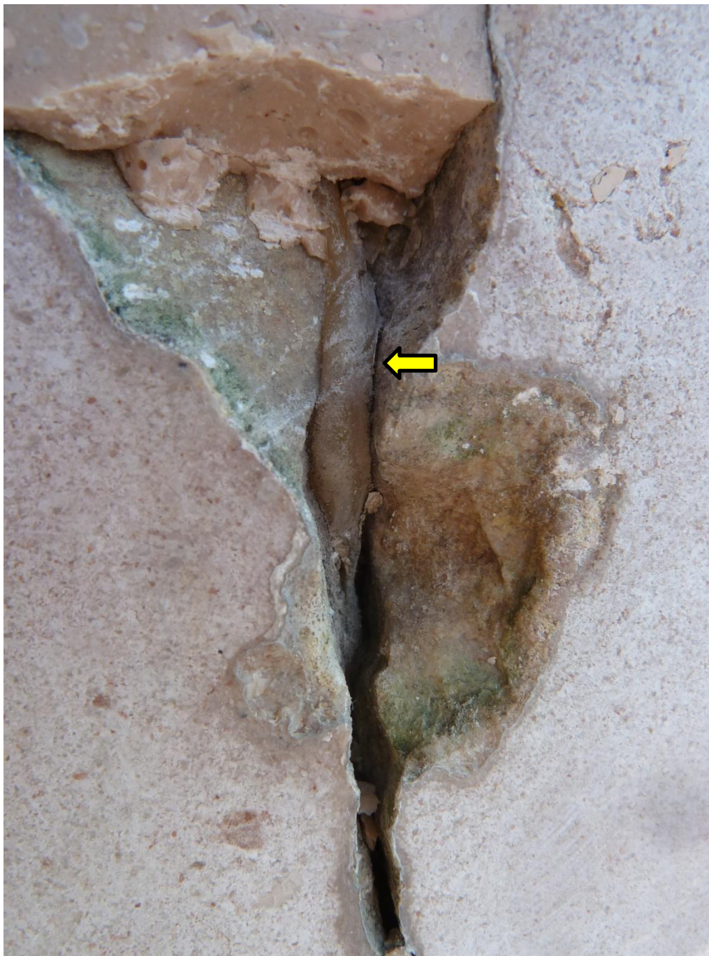
Dřík sloupu – zadní strana (JV) Prasklina v lepeném spoji.
