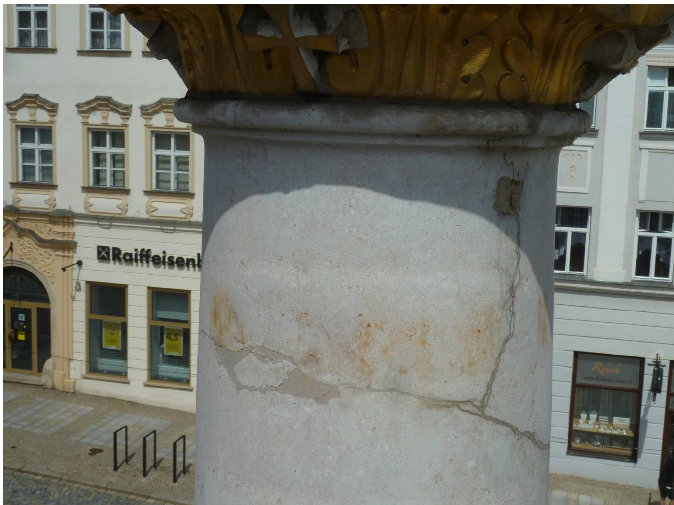
Dřík sloupu – levá strana (SV) Přetmelené praskliny.
