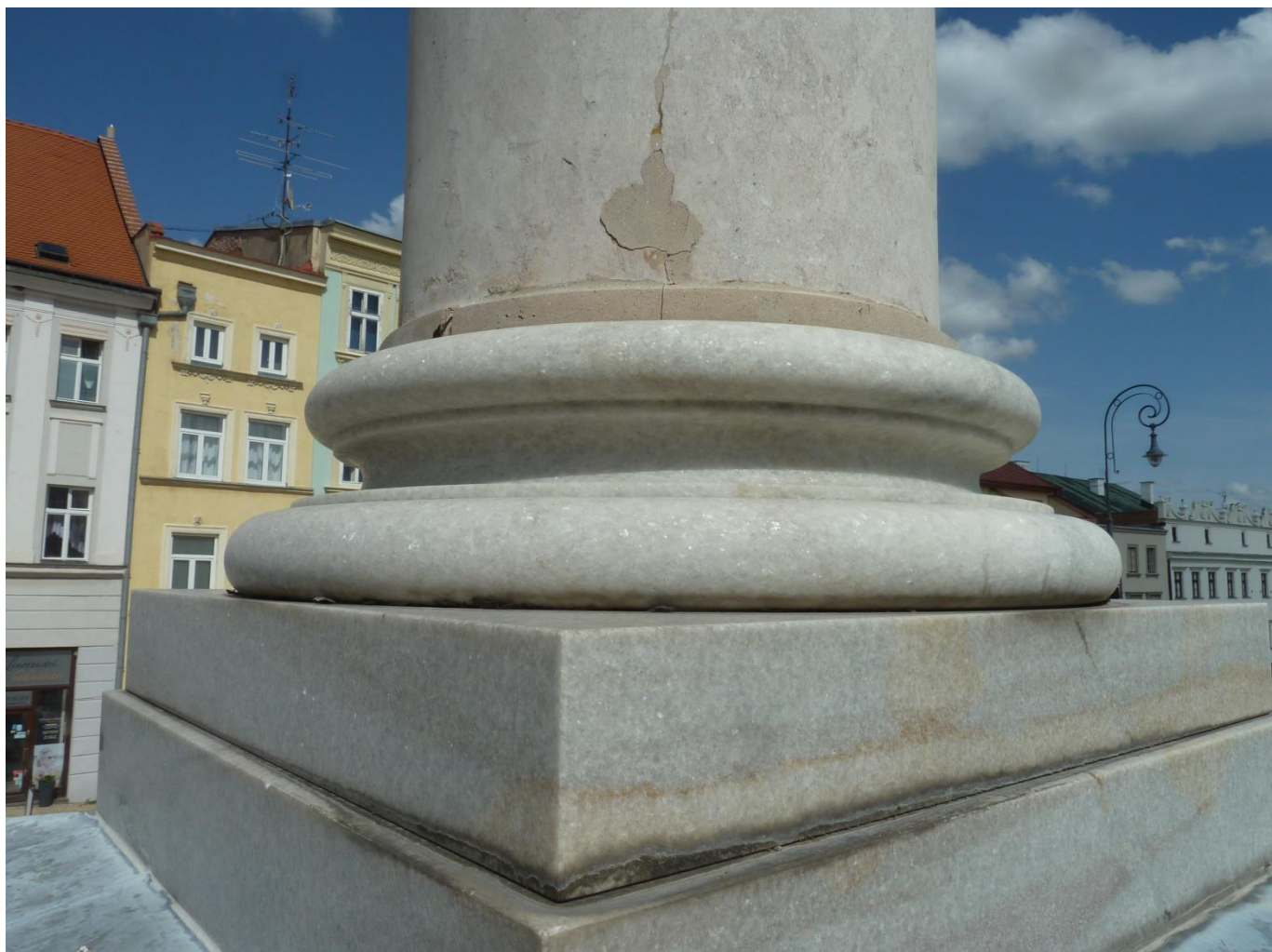
Rekonstrukce patky sloupu provedena v rámci restaurátorských prací v roce 1993 – 1996. Patka ze tří částí, spáry vyplněny silikonovým tmelem.
